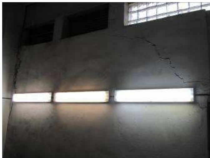
PRŮČELÍ jihozápadní (smykové a tahové trhliny) - sloup A / 4 exteriér _____ interiéř
