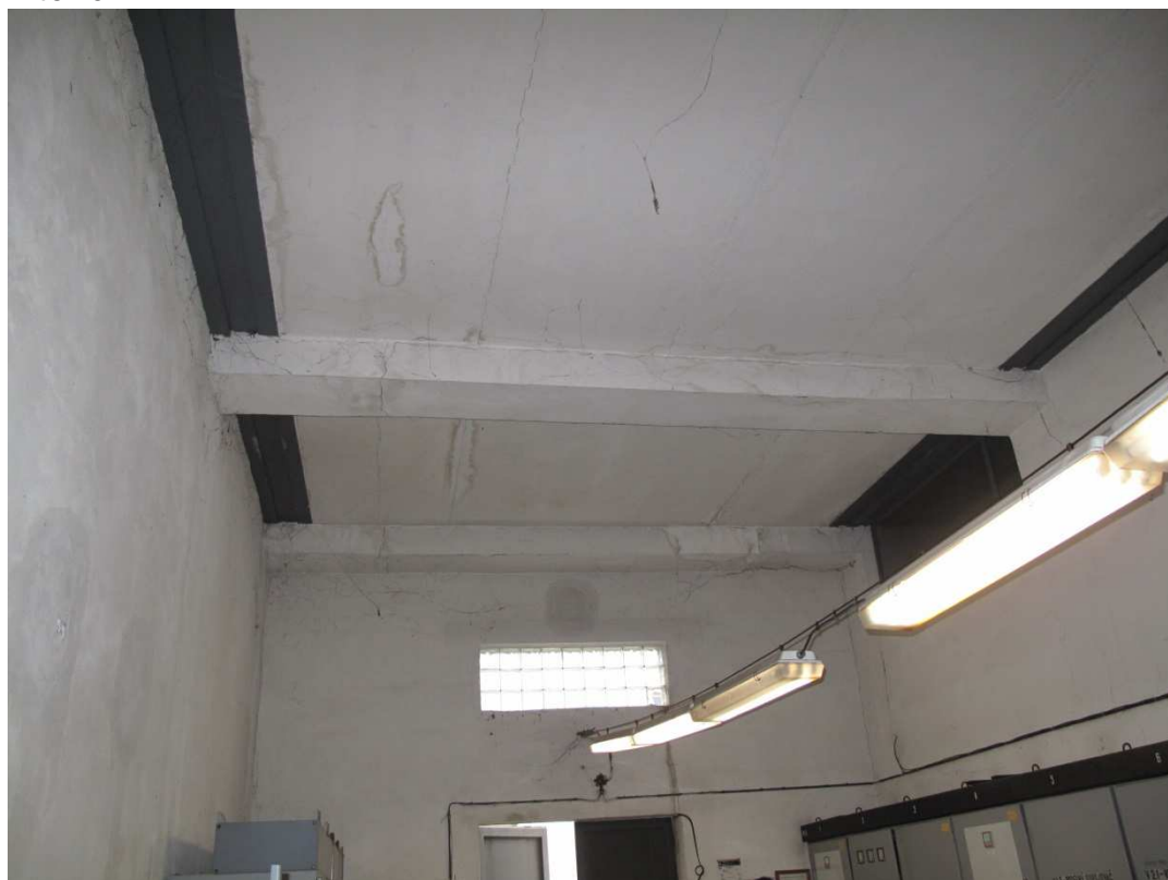
rám (střední), sloup - průvlak - sloup B / 3 interiér
